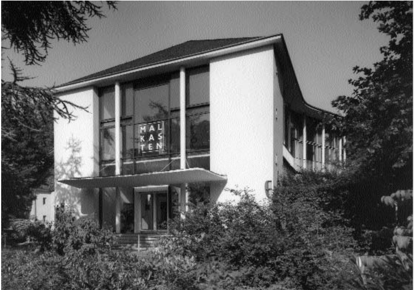
Hauptfront des Vereinsgebäudes; 2000
