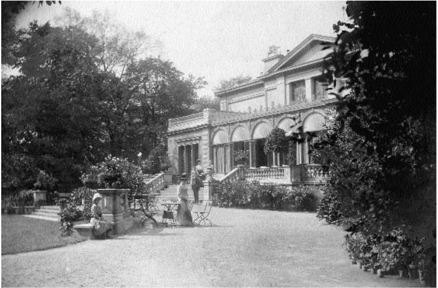
Gartenfassade des Vereinshauses; [1896]; F-Haus 1896-2111
